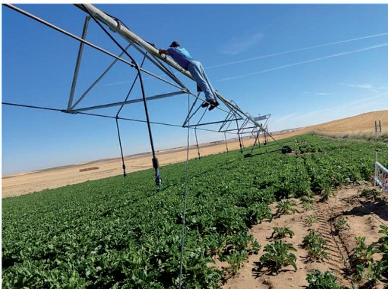
Instalación de Rotator® en los bajantes del pivot del demostrador, por fuera de los tirantes.
