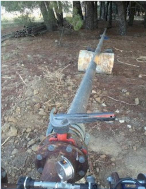
Disminuir pérdidas de carga en las tuberías de la red de riego, en este caso sustituyendo una tubería superficial de aluminio por otra de PVC enterrada de mayor sección.
