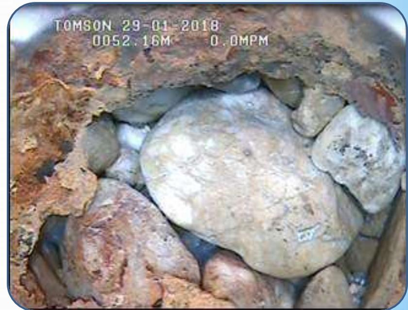
**Rotura de la tubería de revestimiento por el roce continuado de las bridas de la tubería de impulsión.**
