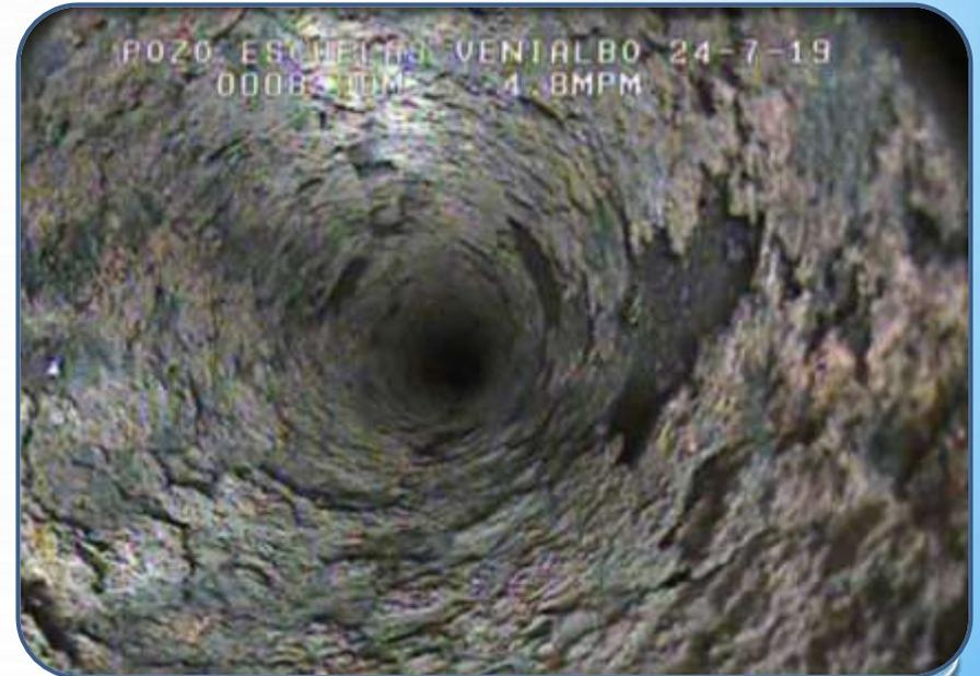
**TUBERÍAS DE REVESTIMIENTO ALTAMENTE OXIDADAS**
