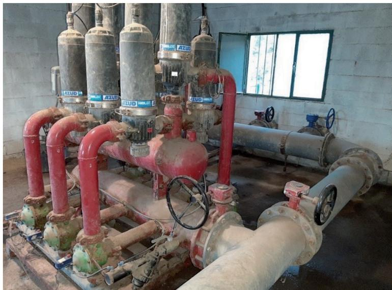
Filtro en mal estado en una instalación de riego por goteo desde balsa
