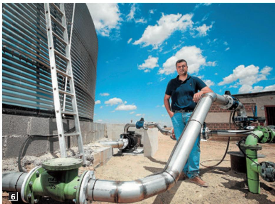
constante en riegos por aspersión de cualquier tamaño, tanto coberturas como pivotes o cañones, sin recurrir al uso de energías convencionales, ni al almacenamiento de energía en baterías o de agua en grandes balsas.
