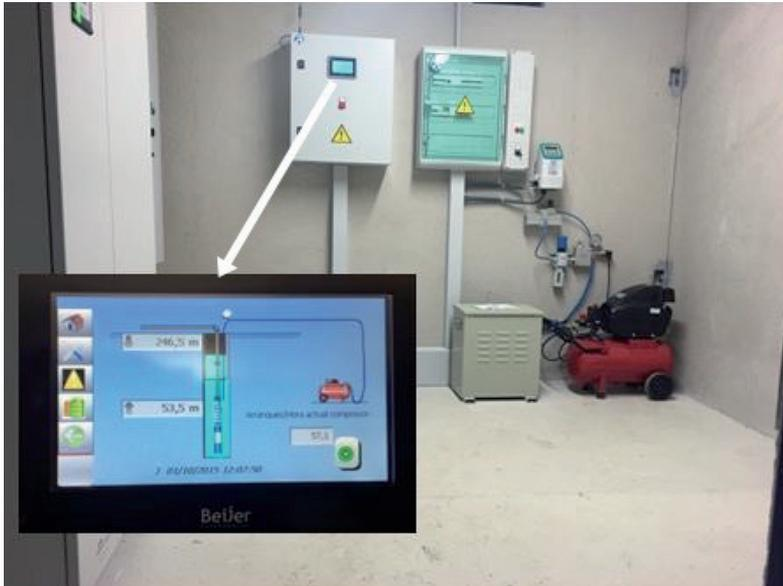
Medidor de nivel de burbujeo continuo.
