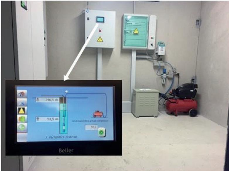
Medidor de nivel de burbujeo continuo.
